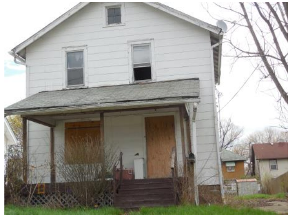
161 N. HAZELWOOD AVE: DEMOLITION
