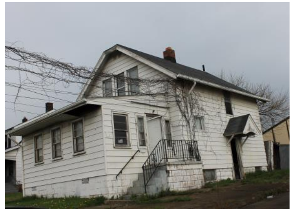
19 N. DUNLAP AVE: DEMOLITION
